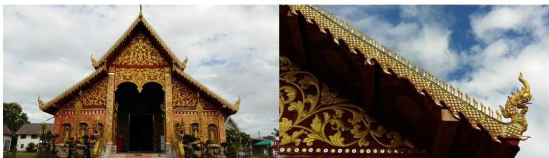
ภาพที่ ๔.๕๕ งานประดับกระจกส่วนใบระกาทางหงส์วิหารวัดเจ็ดยอด
