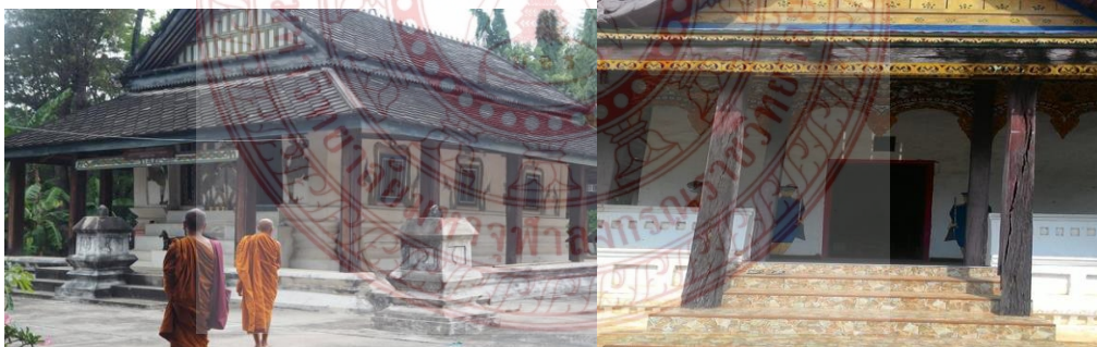
ภาพที่ ๔.๓ ลงพื้นที่สำรวจข้อมูลใบลาน วัดบรมคางคาง จังหวัดบุรีรัมย์
