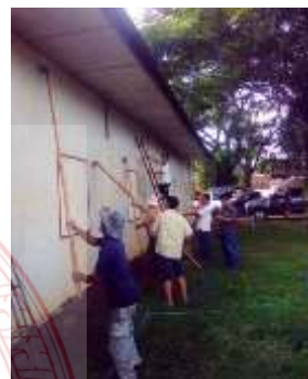
ลงพื้นด้วยน้ำยารองพื้นปูน
