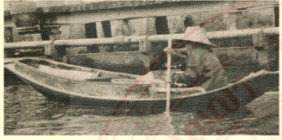
ภาพที่ ๒๒ ฝายบริเวณสะพานข้ามแม่น้ำป่าสักบริเวณตลาดนัดค้าสินค้าในเขตลพบุรี
