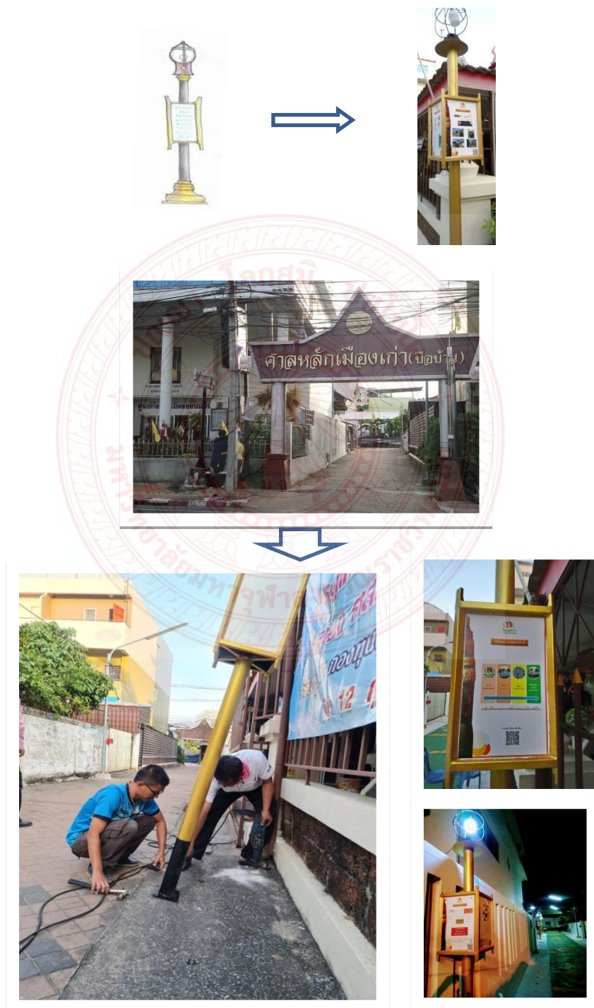
ภาพประกอบที่ ๔.๔๖ แสดงการติดตั้งเสาไฟฟาส่องสว่าง จำนวน ๖ เสา
