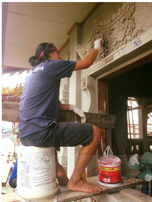
ภาพที่ ๕๒ การสร้างสรรค์งานศิลปกรรมล้านนาด้านประติมากรรมปูนปั้นสตายจีนในยุคปัจจุบัน (การปั้นปูนสดด้วยมือ แต่มีความคงทนถือเป็นเอกลักษณ์เฉพาะของช่างล้านนา) (ที่มา: นายสิทธิชัย บุญฤทธิ (สล่ากาย), ๕ เมษายน ๒๕๖๓)
