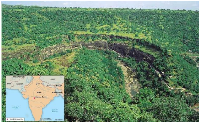
ภาพที่ ๔.๖ สถาปัตยกรรมสมัยคุปตะที่ถ้ำอชันตา (Ajanta caves) ปัจจุบันตั้งอยู่ในรัฐมหาราษฏระ (Maharashtra) ของอินเดีย
