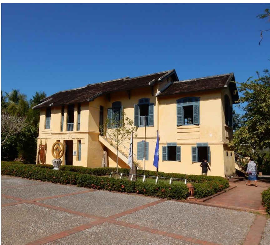
ภาพที่ ๑๓ อาคารที่ทำการห่องการมรดกโลก เมืองหลวงพระบาง อาคารประเภทที่ทำการของหน่วยงาน รัฐบาล ที่ได้รับการขึ้นทะเบียนในการปกป้องรักษา (ถ่ายโดยผู้วิจัยเมื่อวันที่ ๒๖ ธันวาคม พ.ศ.๒๕๕๙)
