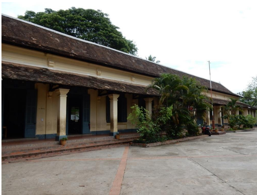
ภาพที่ ๑๔ อาคารโรงเรียนประถมสมบูรณ์ เมืองหลวงพระบาง อาคารประเภทที่ทำการของหน่วยงานรัฐบาล ที่ได้รับการขึ้นทะเบียนในการปกป้องรักษา (ถ่ายโดยผู้วิจัยเมื่อวันที่ ๑๒ มิถุนายน พ.ศ.๒๕๖๐)
