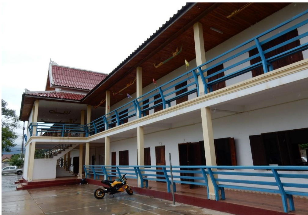
ภาพที่ ๓๓ อาคารเรียนของวิทยาลัยวิจิตรศิลป์พื้นเมืองหลวงพระบาง (ถ่ายโดยผู้วิจัย ๑๕ มิถุนายน พ.ศ. ๒๕๖๐)
