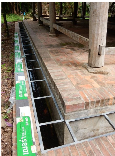
ภาพที่ ๔๕ วัสดุไม้สังเคราะห์ที่ใช้ในการซ่อมอนุรักษ์เรือนจันทร์ (ถ่ายโดยผู้วิจัย ๑๑ มิถุนายน พ.ศ.๒๕๖๐)
