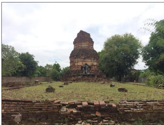
แผนภาพที่ ๓.๑๓ เขตพระวิหารวัดอาทิตันแก้วในปัจจุบัน
