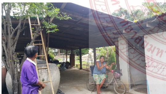
ภาพที่ ๔.๕๘ ต่อหลังคาเพื่อกันฝนตามแนวทางเดินเข้าห้องน้ำ เพื่อสะดวกในการเข้าห้องน้ำในหน้าฝน
