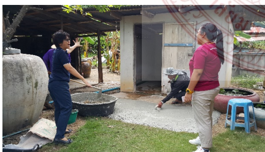
ภาพที่ ๔.๒๙ ปรับพื้นด้านหน้าห้องน้ำให้มีลักษณะลาดเอียง เชื่อมต่อกับช่องทางที่เปิดออก
