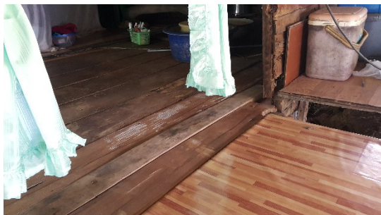
ภาพที่ ๔.๒๖ ปูพื้นด้วยเสื่อน้ำมันเพื่อป้องกันเสี้ยน และทำการติดผ้าม่านบังตา พร้อมราวจับกันตก
