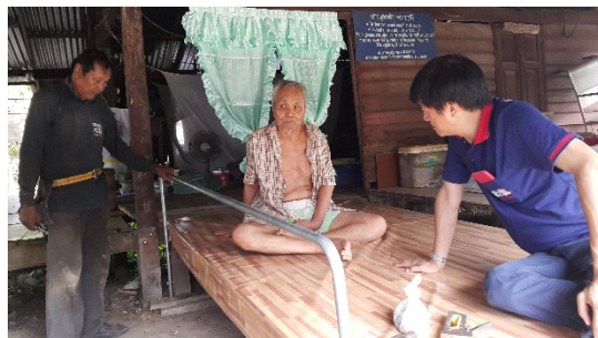
ภาพที่ ๔.๒๖ ปูพื้นด้วยเสื่อน้ำมันเพื่อป้องกันเสี้ยน และทำการติดผ้าม่านบังตา พร้อมราวจับกันตก
