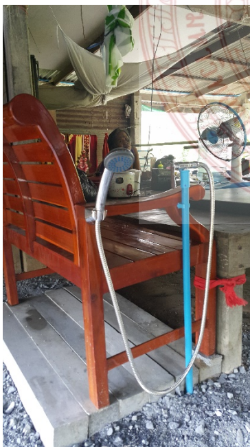
ภาพที่ ๔.๔๒ ต่อระบบประปาและติดตั้งฝักบัวอาบน้ำ
