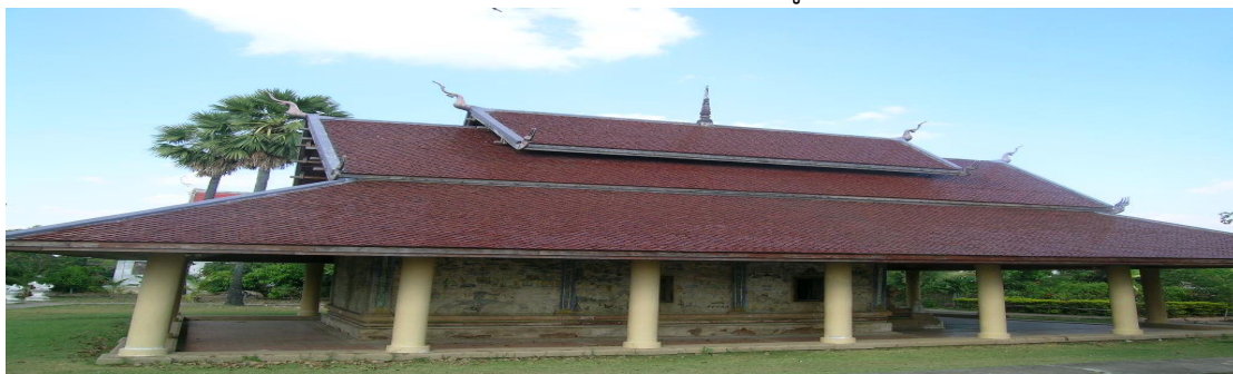
แผนภาพที่ ๔๓ ลิมอีสานพื้นบ้านบริสุทธิ์ชนิดลิมโปร่ง หรือลิมโถงวัดสระบัวแก้วบ้านวังคุณ ตำบลหนองเม็ก อำเภอนองสองห้อง จังหวัดขอนแก่น (๑)
