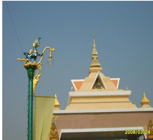
ประติมากรรมรูปสีโหบนเสาไฟฟ้าในเวลากลางวัน
