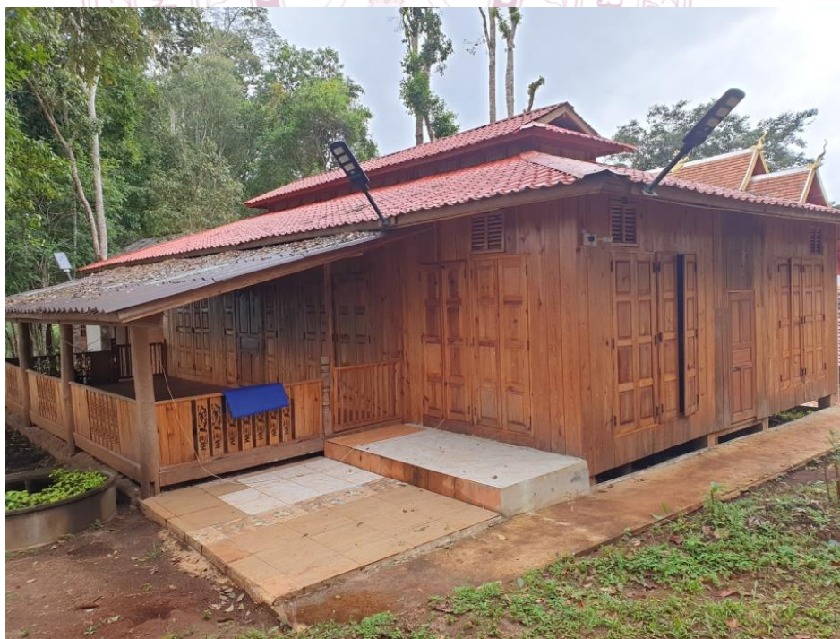
ภาพที่ 4.70 อาคารเรือนที่พัก
