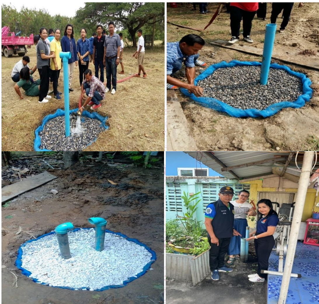
ภาพ ๔.๑ การจัดทำธนาคารน้ำใต้ดินแบบพอเพียง(ระปิด)แบบครัวเรือนตำบลกลางแดด
