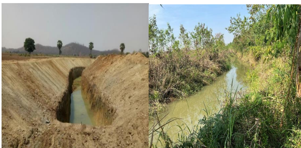
ภาพที่ ๔.๑๐ ธนาคารน้ำใต้ดินแบบพอยเพียง(ระบบเปิด)แบบเดิมประยุกต์ตำบลหนองมะโมง
