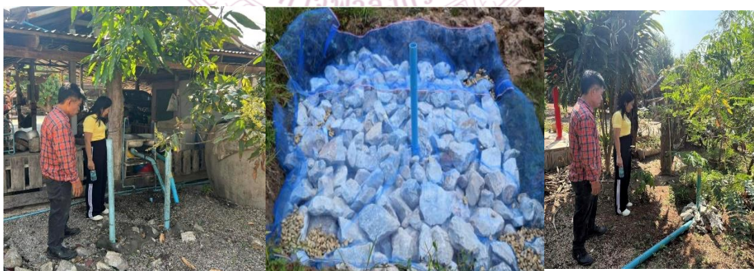
ภาพที่ ๔.๗ ธนาคารน้ำใต้ดินแบบพองเพียง(ระบบปิด)ในพื้นที่ตำบลหนองมะโมง
