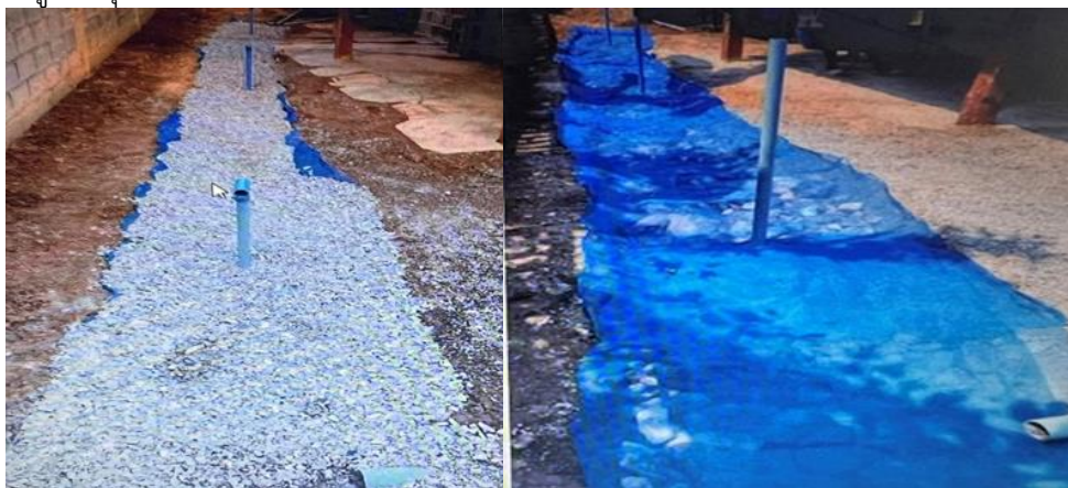
ภาพที่ ๔.๘ ธนาคารน้ำใต้ดิน(ระบบปิด) แบบวางระบายน้ำในพื้นที่ตำบลหนองมะโมง
