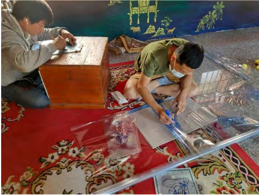
การร่างแบบ ในบางจุดที่มีพื้นที่จำกัด (ทำหน้างานเท่านั้น)
