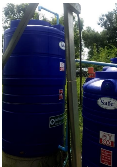
ภาพที่ 4.7 พัฒนาระบบที่และการกักเก็บระบบน้ำไว้หนึ่งวันก่อนนำไปใช้ประโยชน์ ที่มา : คณะผู้วิจัย
