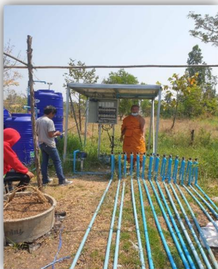
ภาพที่ 4.2 แสดงการวางระบบจ่ายน้ำ และทดสอบประสิทธิภาพการทำงานของระบบจ่ายน้ำ ที่มา : คณะผู้วิจัย 10 ธันวาคม 2564
