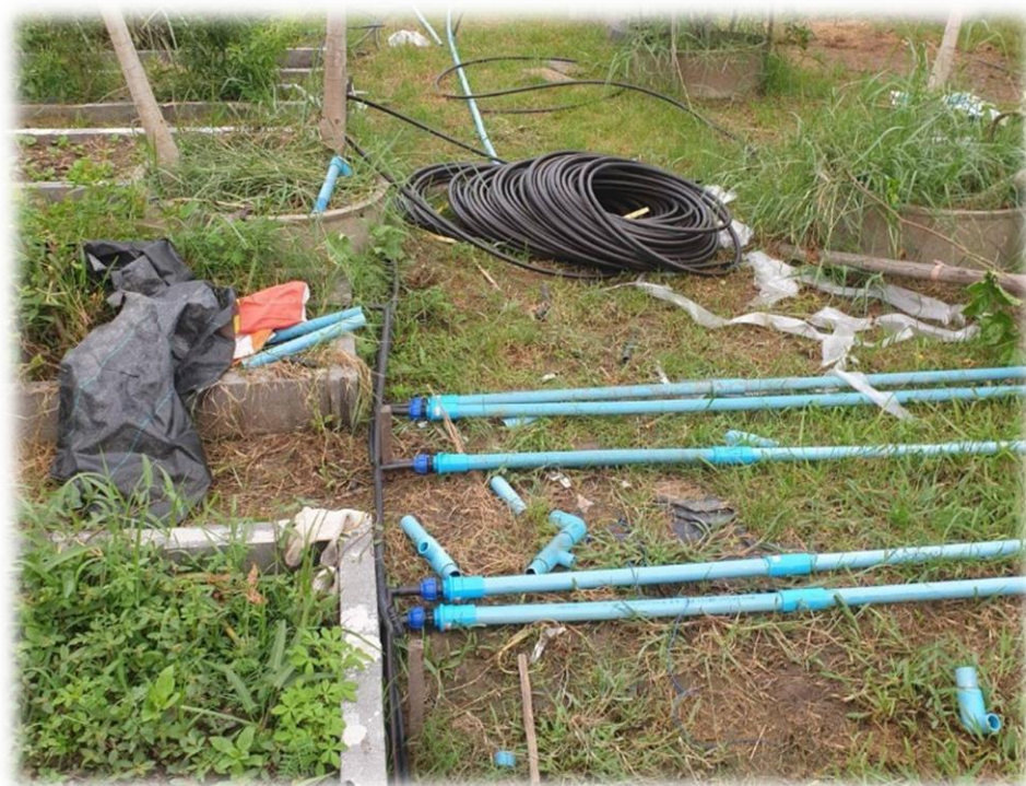
ภาพที่ 4.1 แสดงการเตรียมการวางระบบน้ำบำบัดเสียจากบ่อก่อนนำมาใช้ลดฝักสวนครัว ที่มา : คณะผู้วิจัย 10 ธันวาคม 2564
