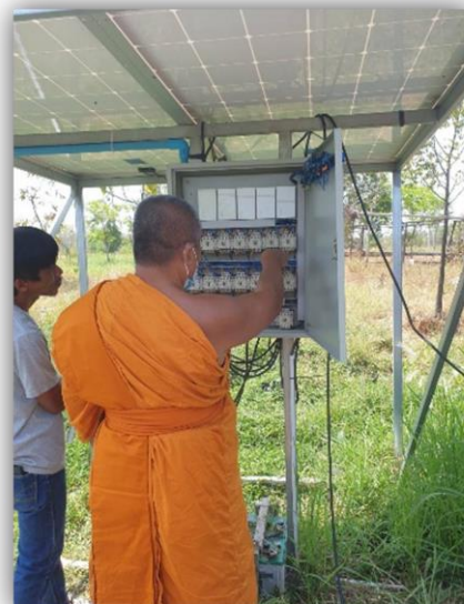
ภาพที่ 4.2 แสดงการวางระบบจ่ายน้ำ และทดสอบประสิทธิภาพการทำงานของระบบจ่ายน้ำ ที่มา : คณะผู้วิจัย 10 ธันวาคม 2564
