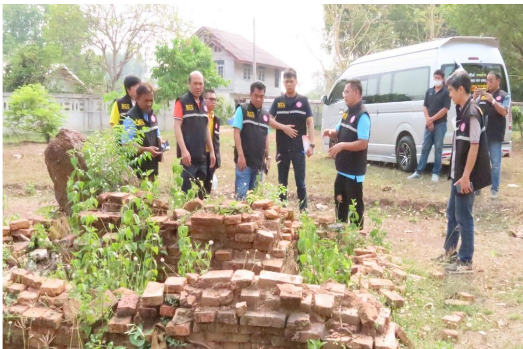
ภาพที่ ๔.๒๙ คณะผู้วิจัยลงพื้นที่สำรวจวิหารพระนอน อำเภอเมือง จังหวัดหนองคาย
