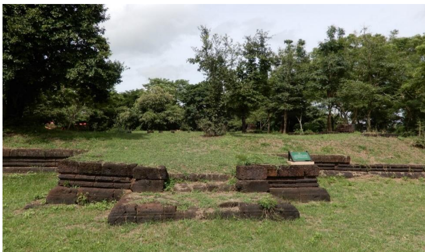
ภาพที่ ๘ อาคารพลับพลาของปราสาทหินพนมวัน
