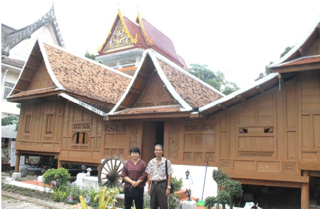
กุฎิทรงไทยภาคใต้ วัดวังตะวันตก อำเภอเมือง จังหวัดนครศรีธรรมราช
