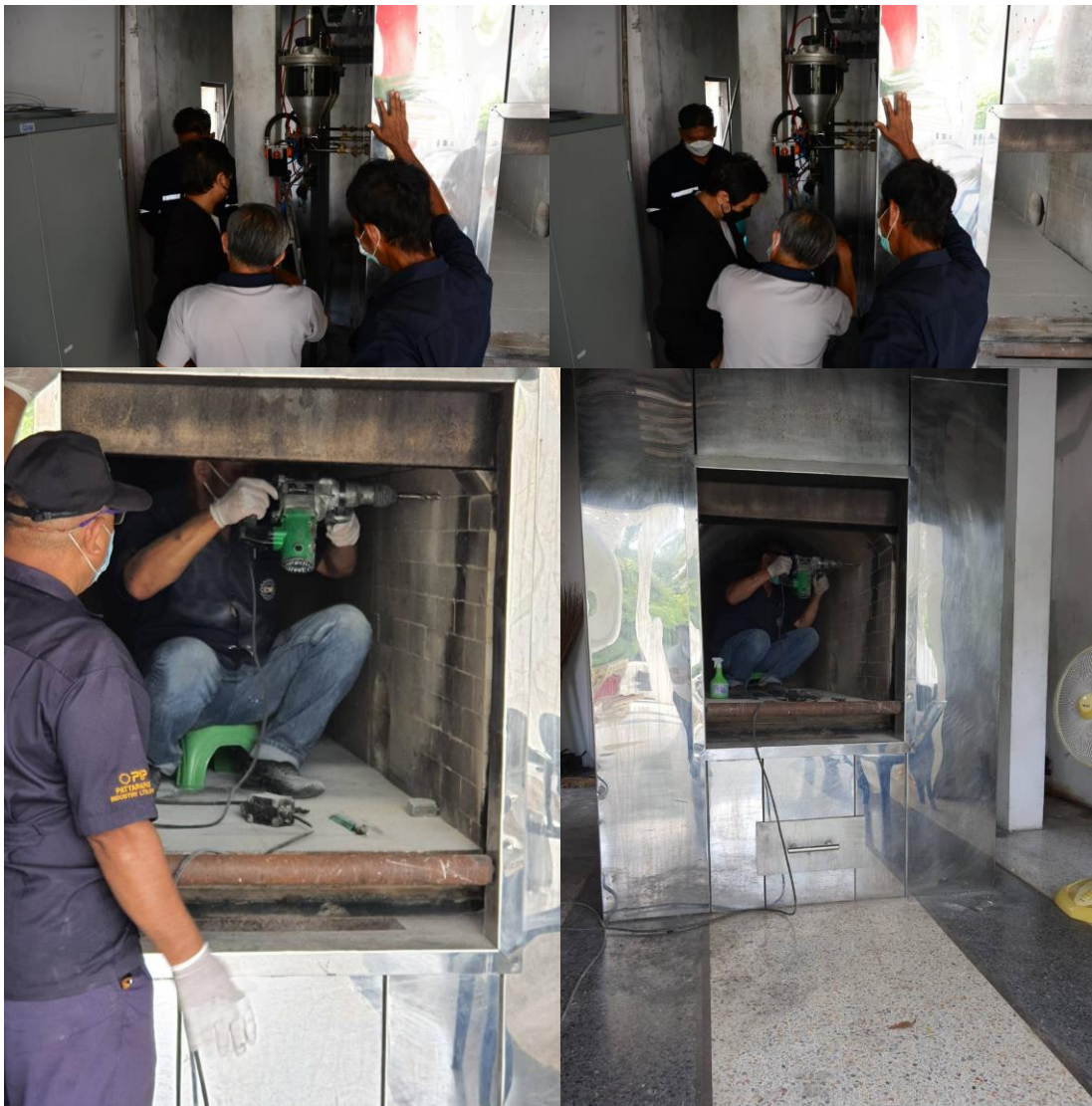
ภาพที่ 4.7 แสดงทีมงานดำเนินการปรับเตาเผาศพเก่าให้สามารถรองรับเครื่องฟนสารวิมุตติ พร้อมหัวฉีดวิมุตติ เพื่อการทดลองใช้จริง ที่วัดพิรุณศาสตร์ ที่มา : คณะผู้วิจัย 2564
