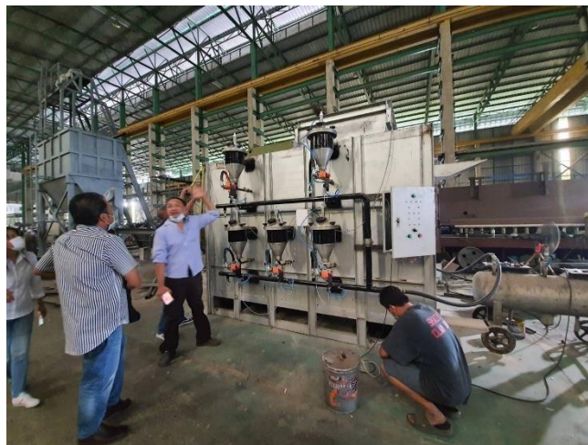
ภาพที่ 4.3 เครื่องฟั่นสารวิมุตติ และเตาเผาศพต้นแบบเพื่อทดลองใช้สารวิมุตติในการเผาปนกิจ ที่มา : คณะผู้วิจัย 2564
