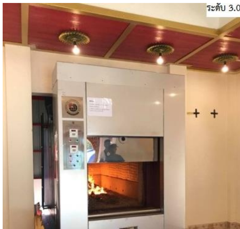
ภาพที่ 2.4 แสดงมาตรฐานเตาเผาศพระดับ 3.0 ที่มา : กรมควบคุมมลพิษ
