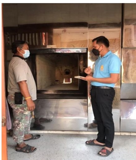
ภาพที่ 4.5 เตาเผา 2 ห้องเผา ระบบน้ำมันดีเซล ที่มา : พระเทพปริยัติเมธี,รศ.ดร.และคณะวิจัย
