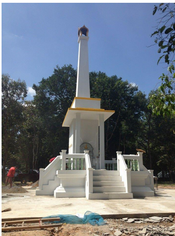
ภาพที่ 4.3 เตาเผา 1 ห้องเผา ใช้ถ่านเป็นเชื้อเพลิง ที่มา : พระเทพปริยัติเมธี,รศ.ดร.และคณะวิจัย
